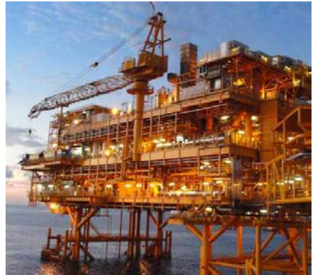
LNG (Liquid Natural Gas)
